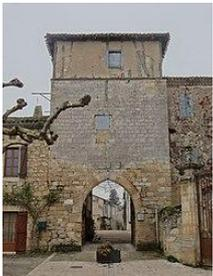
Tour-porte du 13e siècle située au nord XXX du village. Comporte trois niveaux, deux en maçonnerie et le dernier en pan-de-bois. La porte est en arc brisé. Le couloir est couvert d'une voûte en berceau. Il était fermé par de simples vantaux dont le système de blocage est encore visible. L'accès à l'étage se faisait par une porte percée dans la face interne de la tour. Cette porte aujourd'hui obturée est encore visible.
