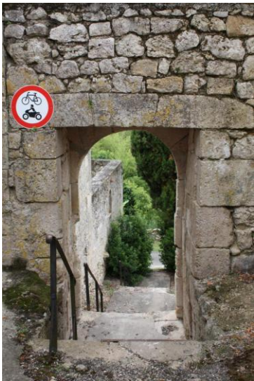
Porte piétonne (vue arrière).
