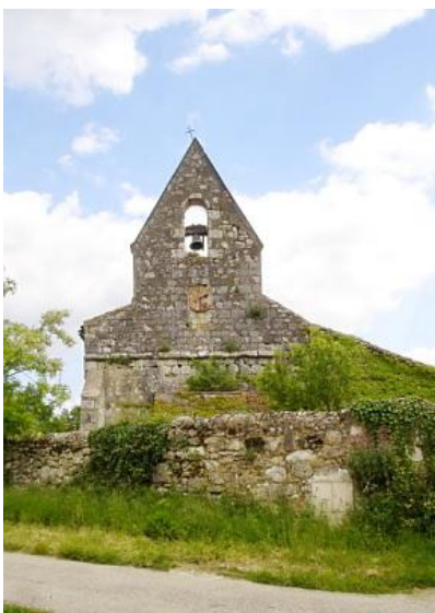
Chapelle de Tressens (clocher)
