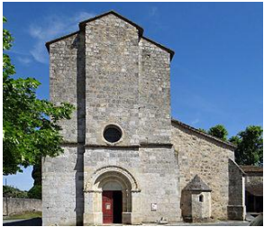
Façade occidentale et portail.
