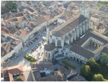
Eglise Saint-Pierre (chapelles latérales et contreforts).
